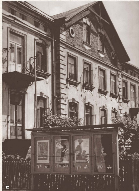
Kamienica czynszowa Giepardów przy ulicy Kolejowej 17. Był to najbardziej reprezentacyjny gmach w dawnym Wierzbniku, wyróżniający się wielkością i ozdobną elewacją fasady. W latach I wojny światowej mieściła się tu siedziba okupacyjnych władz austro-węgierskich. Na pierwszym planie znajduje się gablota z plakatami filmowymi kina, które znajdowało się na lewo od kamienicy; fotografia z połowy lat 50. XX w.
