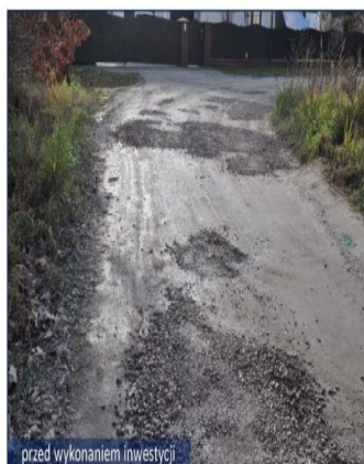
przed wykonaniem inwestycji
