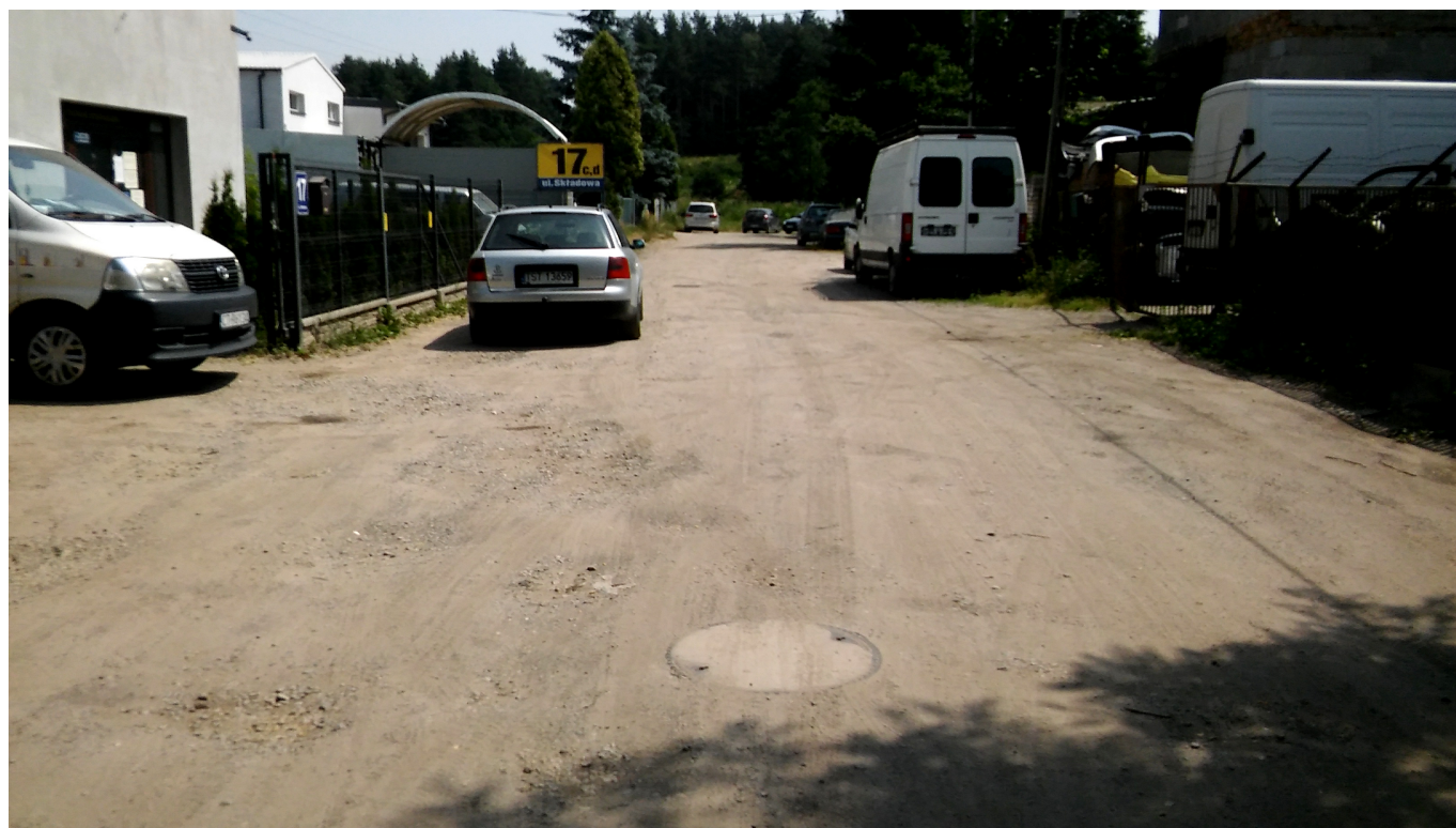
Odcinek ul. Składowej przed inwestycją...
