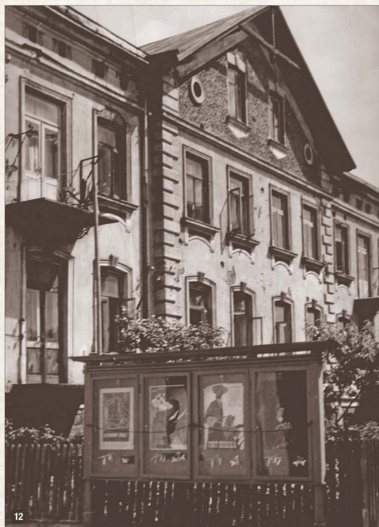
12 Kamienica czynszowa Giepardów przy ulicy Kolejowej 17. Był to najbardziej reprezentacyjny gmach w dawnym Wierzbniku, wyróżniający się wielkością i ozdobną elewacją fasady. W latach I wojny światowej mieściła się tu siedziba okupacyjnych władz austro-węgierskich. Na pierwszym planie znajduje się gablota z plakatami filmowymi kina, które znajdowało się na lewo od kamienicy; fotografia z połowy lat 50. XX w.
