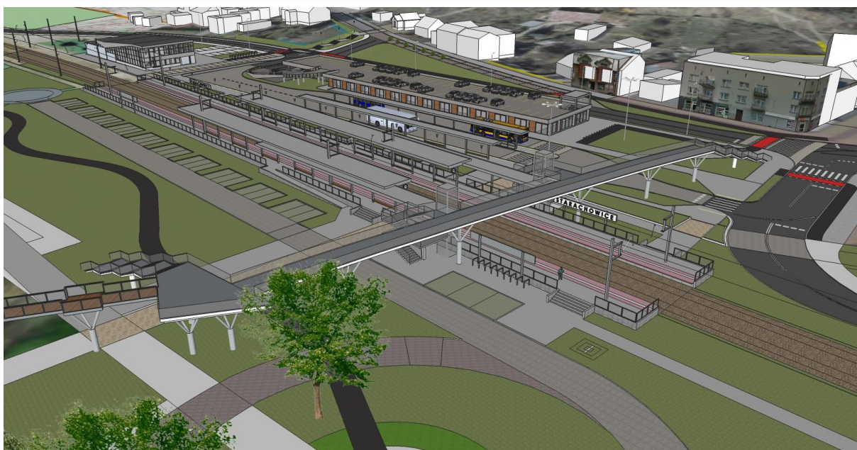
Rys. 4. Widok na perony, dworzec autobusowy, przejście nad torami kolejowymi.
