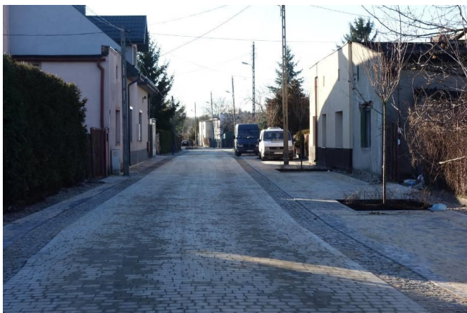
Rys. 9. Ulica Pszenna po modernizacji, źródło: [12]
